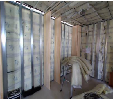
断熱材充填→ボード貼り
