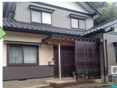
外壁を張替えて雪囲いをしました
