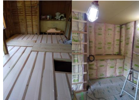
床、壁・天井と隙間なく断熱施工
