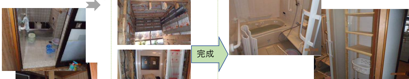
ユニットバス入替、浴室の断熱改修、段差解消
