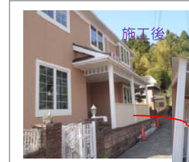
ポーチ(新設)拡大
