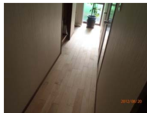
既存床の張替
